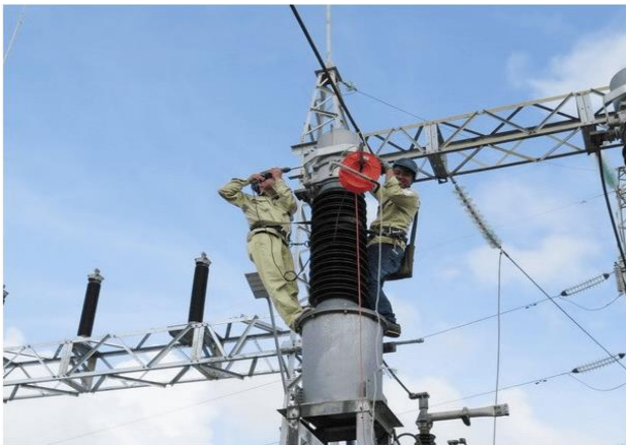
Hình 2. Lắp đặt đường dây cung cấp điện
