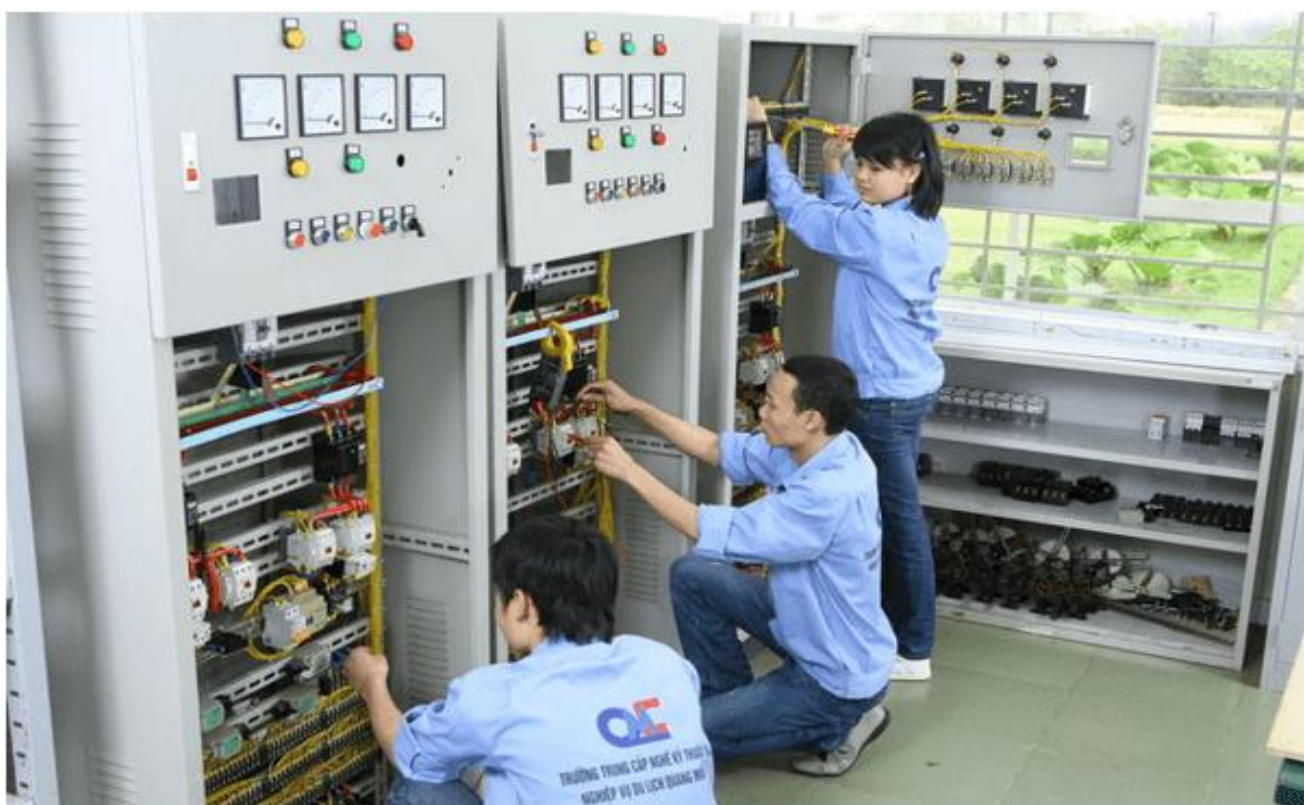
Hình 1. Thợ điện thực hiện các công việc tại nhà máy
